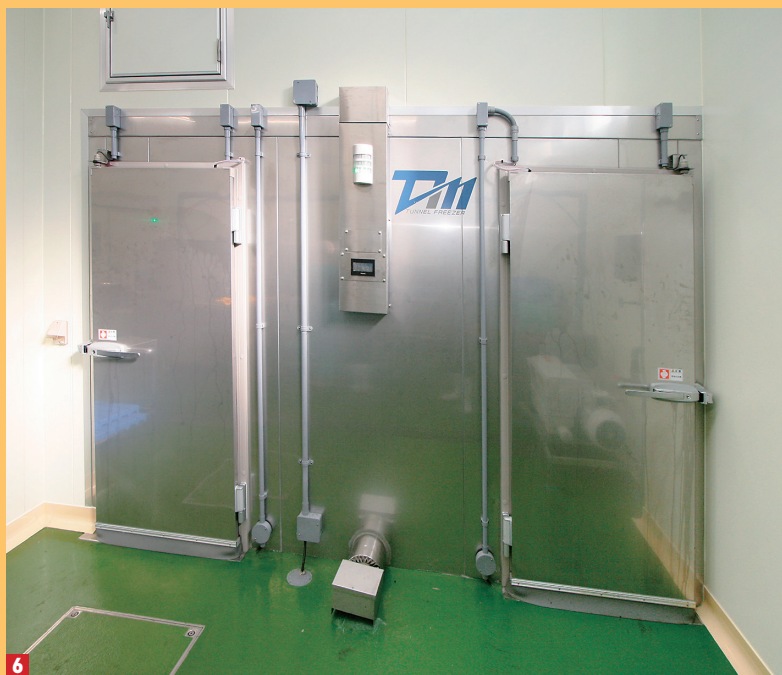
6 以前はアルコール凍結を行っていたが、新工場稼働を機にトンネルフリーザー®を導入。赤身の部分が色落ちしないよう約10分間急速凍結する
